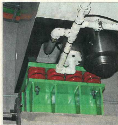
Eines der Federpakete, auf denen die 700-Tonnen-Pressen steht. Die für die 2000-Tonnen-Pressen sind noch größer.
